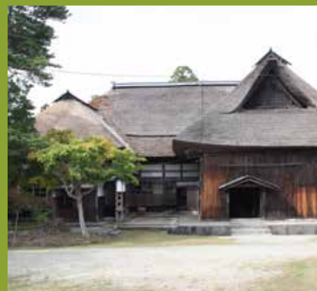
旧奈良家住宅 重要文化財 check
