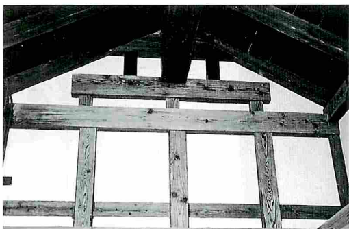
同上 小屋組 (東妻部)
