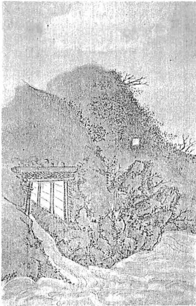
図3 太良鉱山坑口 (菅江真澄「しげきやまもと」より)
