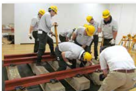
三線軌条敷設風景
