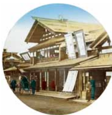
ガラス乾板写真(当館蔵)に見る大町の風景(明治時代)
