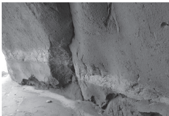
第8図 海食洞内東側のF1断層を断層面の走向方向から観察したもの。
