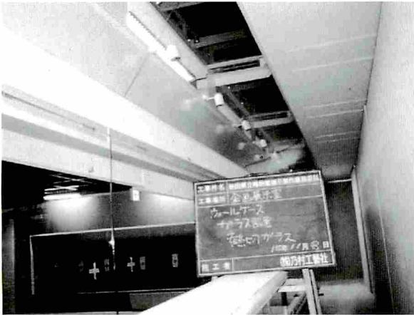
図14 ランプハウス熱線カットガラス設置
