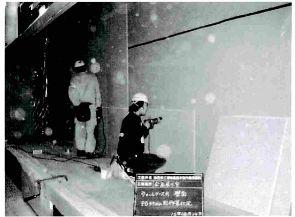
図12 防湿シートを挟み内装ボード張り
